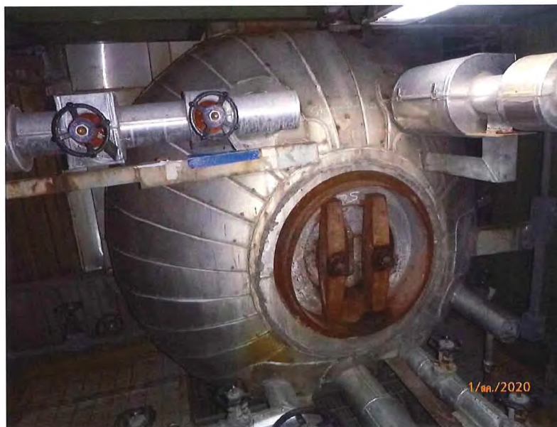
ภาพโดยรวมภายในของหม้อไอน้ำขณะทดสอบแรงดัน
